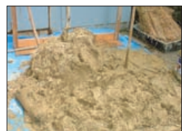
荒壁の施工には手間がかかりました。
