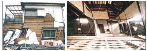
阪神・淡路大震災における木造建築物の地震被害
