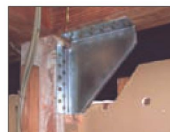
仕口ダンパー取付施工写真
