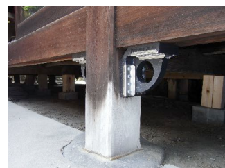
寺院改修の床下設置事例
