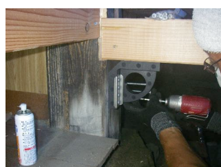
木造住宅の床下施工
