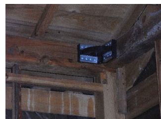
木造住宅2階床面（水平）への施工
