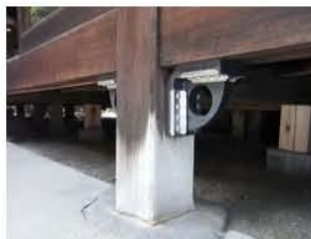
寺院改修の床下設置事例
