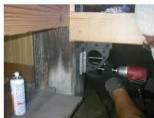
木造住宅の床下施工
