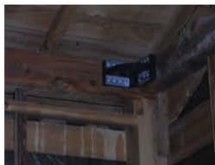
木造住宅天井面（水平）への施工
